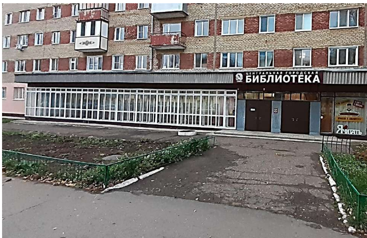
Реконструкция фасада центральной городской библиотеки в рамках ИПМИ-2022.
